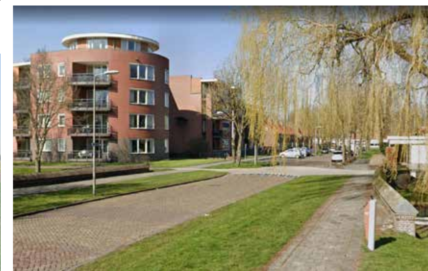
Vervangende nieuwbouw in Marknesse; foto: Google streetview
